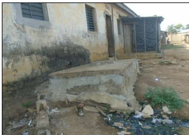
Photo n° 2 : Une fosse en arrière-cour de plus de 30 ans d'existence à Andokoi
